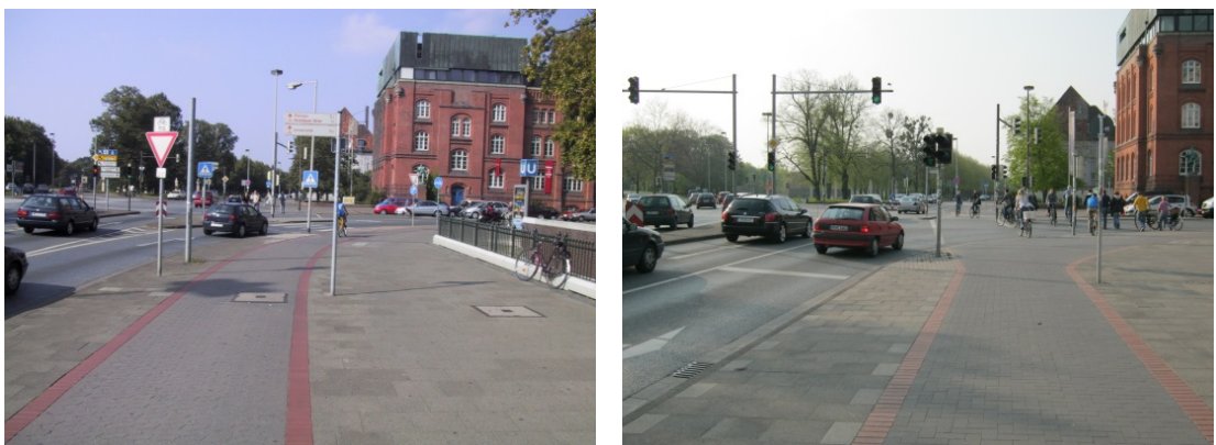
Abb. 5-21: Rückbau und Signalisierung eines konfliktträchtigen freien Rechtsabbiegefahrstreifens in Hannover (links vorher, rechts nachher)
