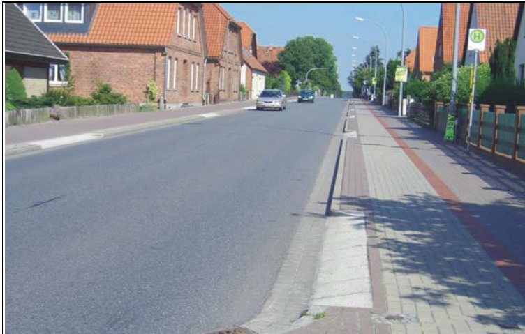
Abb. 5-3: Grundstückszufahrten mit Rampenstein (Soltau)
