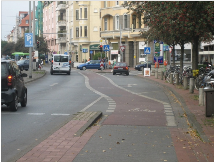
Abb. 5-19: Übergang Radweg in Radfahrstreifen an signalisiertem Knotenpunkt (Hannover)
