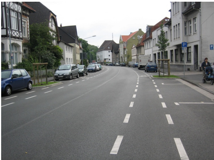
Abb. 5-12: Schutzstreifen mit Sicherheitstrennstreifen zu parkenden Kfz (Lemgo)
