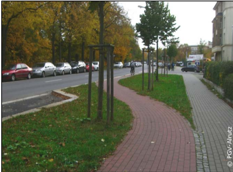
Abb. 5-17: Radverkehr wird im Vorfeld des Knotens an den Fahrbahnrand und damit ins Sichtfeld des Kfz-Verkehrs geführt
