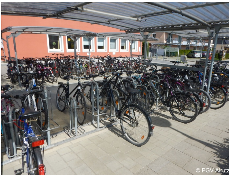
Abb. 6-2: Vorderradgabelhalter am S-Bahn-Halt Gröbenzell
