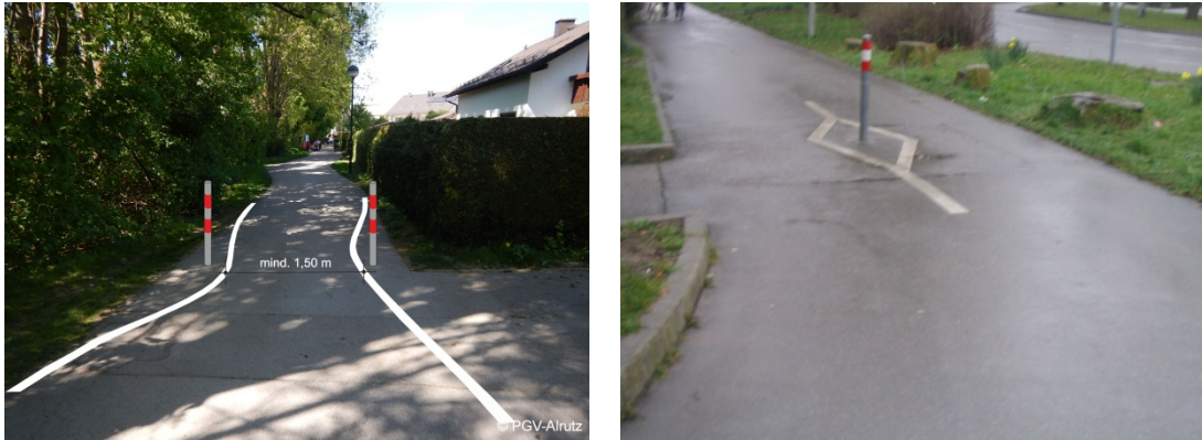
Abb. 5-32: Lösungsansatz inkl. Bodenmarkierungen an Pollern als Fotomontage in Gröbenzell (links) und Beispiel für Bodenmarkierung in Stuttgart (rechts)
