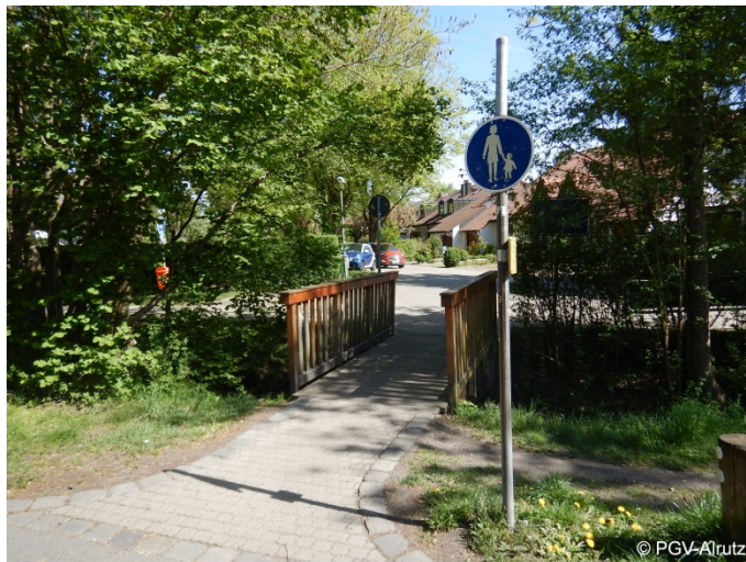
Abb. 5-27: Engstelle durch Fußgänger-Brücke in der Wettersteinstraße mit unzureichender Geländerhöhe
