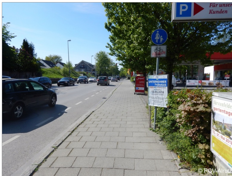
Abb. 5-14: Kombination von Schutzstreifen mit Gehweg, Radverkehr frei (Gröbenzell, Olchinger Straße)
